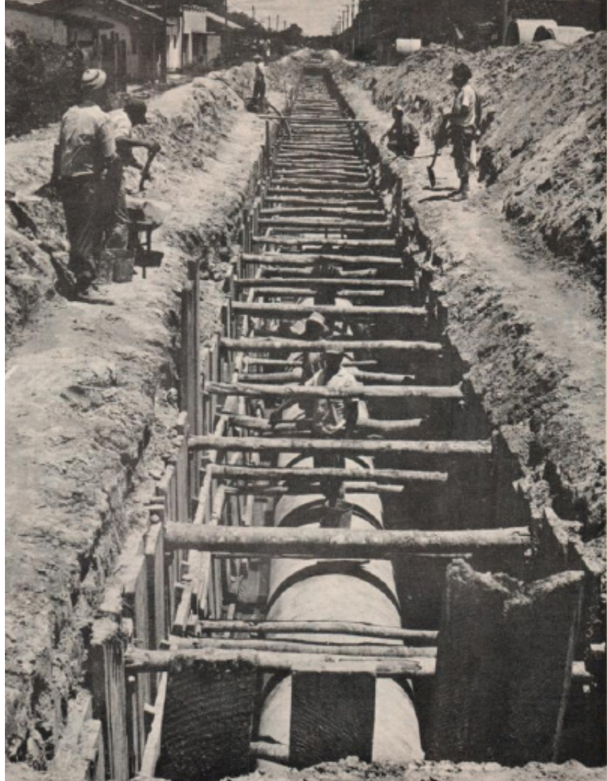
Obras de instalación del servicio de alcantarillado sanitario
