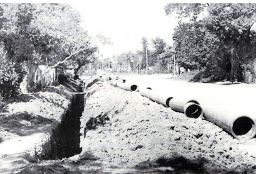
Obras de instalación del servicio de alcantarillado sanitario
