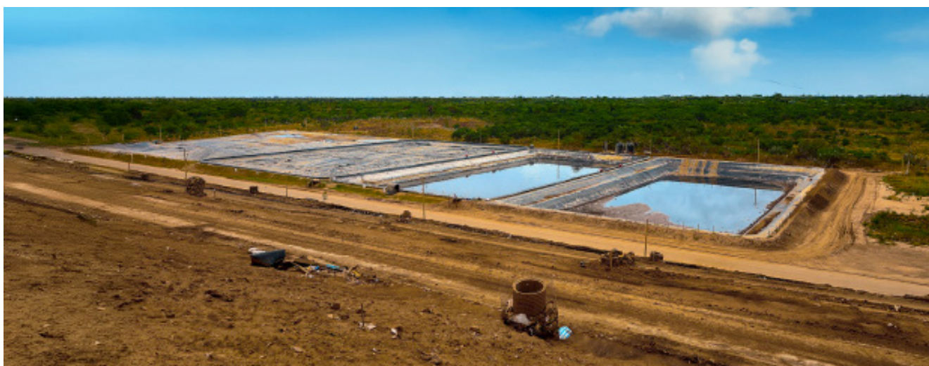
Relleno Sanitario de San Miguel de los Junos, Santa Cruz de la Sierra
