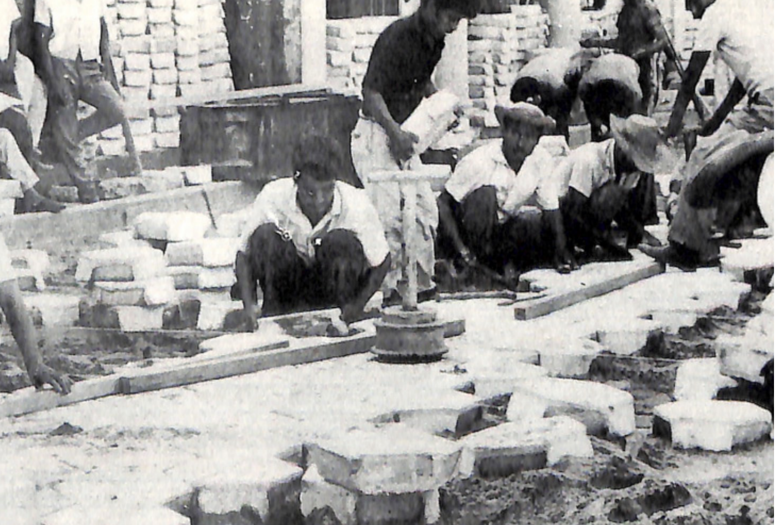
Colocado de losetas
