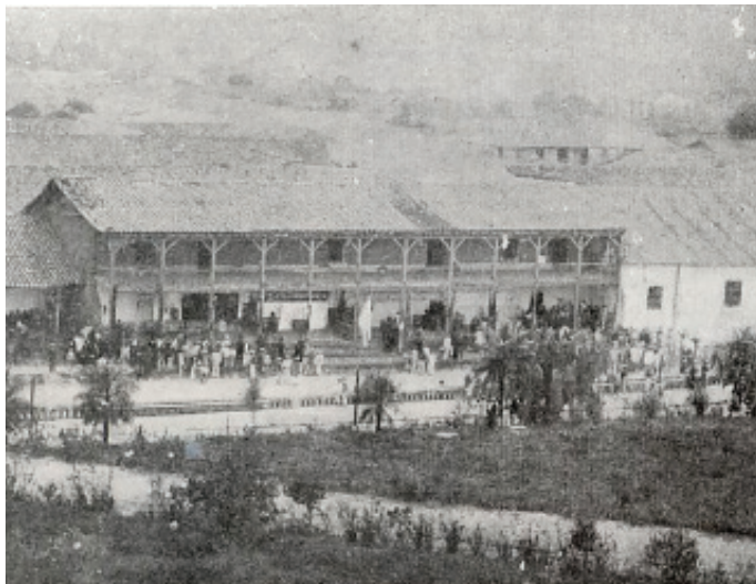
Colegio Seminario (acera oeste de la Plaza Principal), 1884
