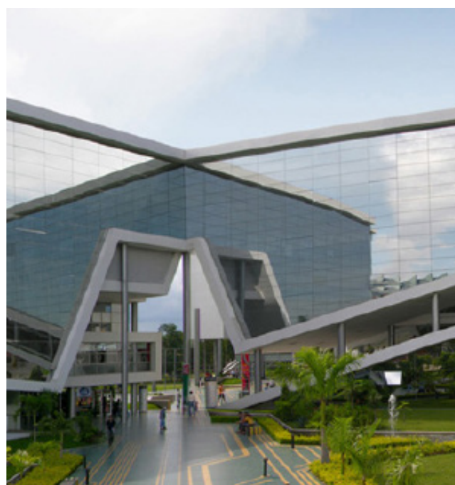
Vista de edificio Universidad Técnica Privada de Santa Cruz “UTEPSA”
