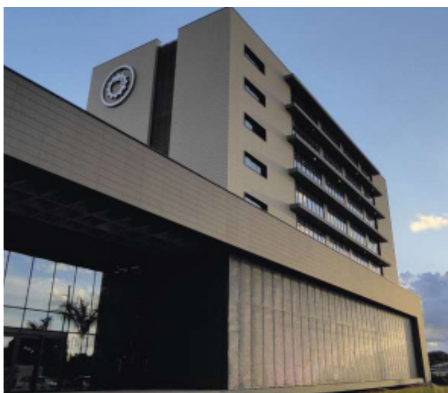
Vista de edificio Universidad del Valle “UNIVALLE”
