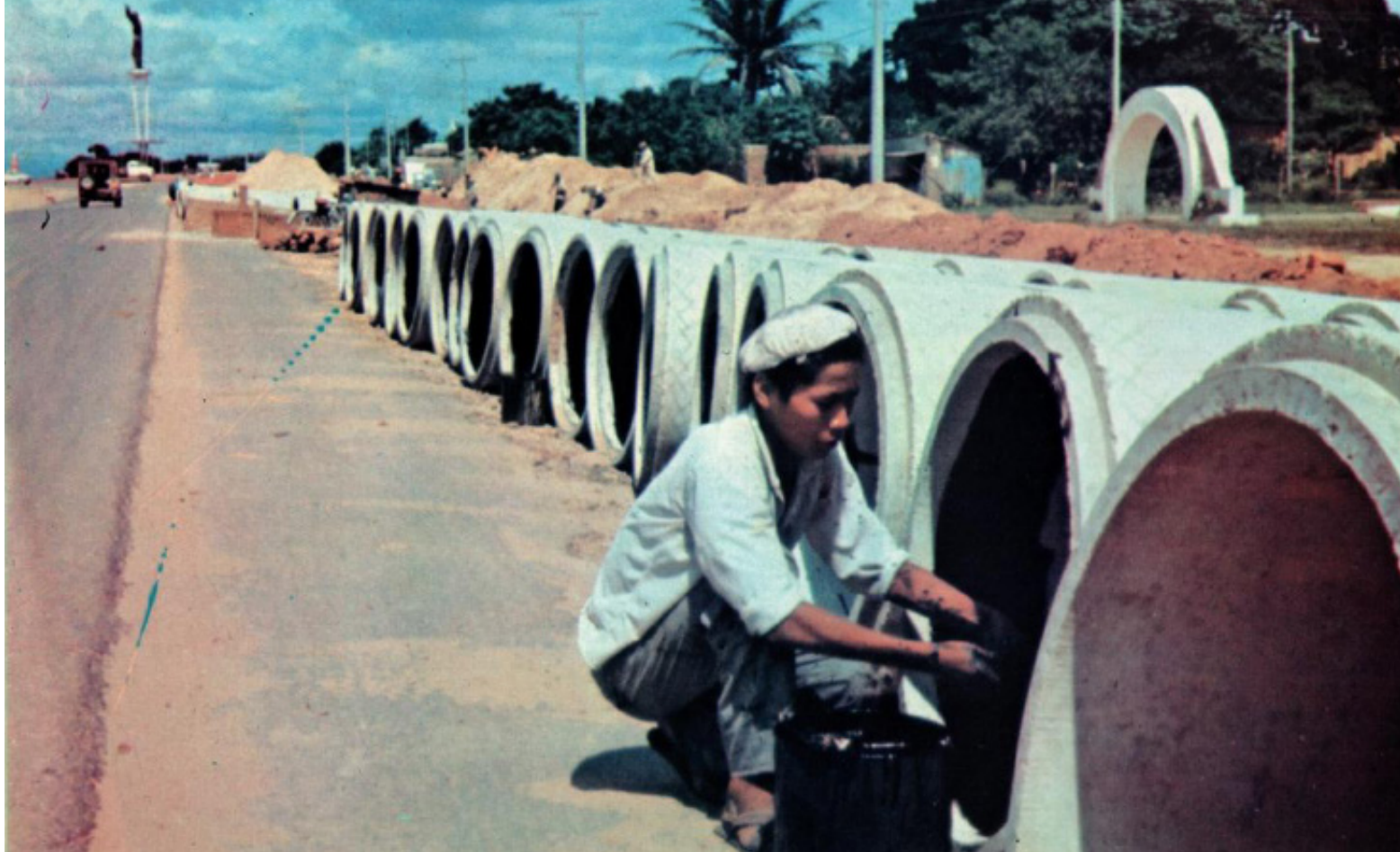
Instalación de alcantarillado sanitario, Av. Cristobal de Mendoza 2do anillo
