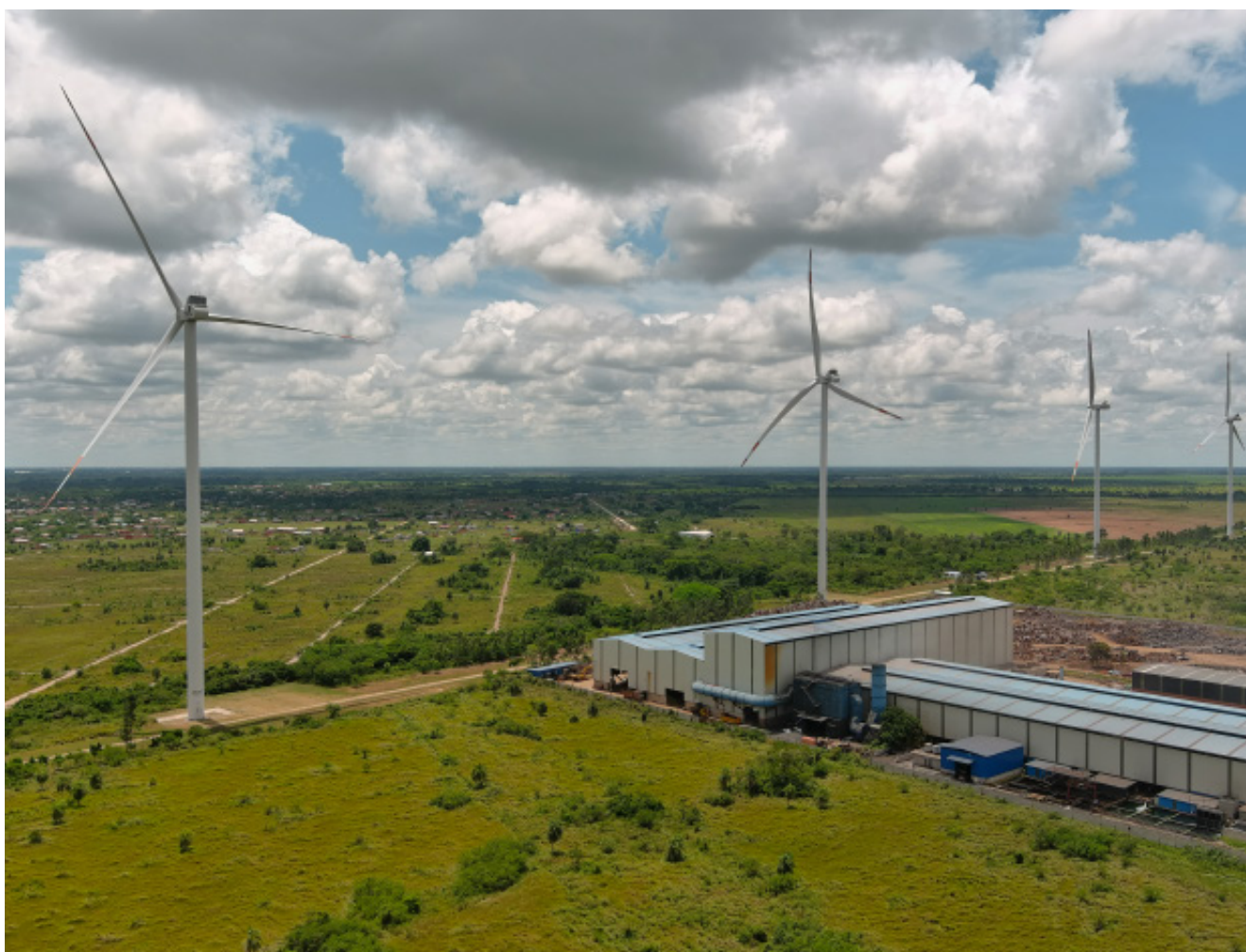
Generadores eólicos, Parque Eólico Warnes
