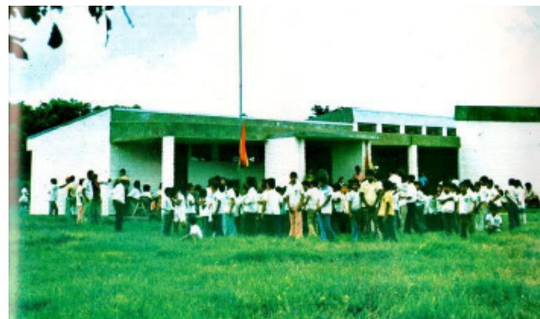
Escuela construida por el Comité de Obras Públicas
