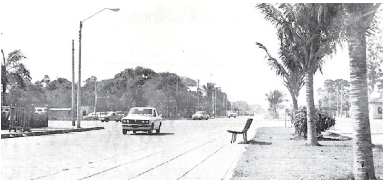
Obra del Comité de Obras Públicas y los recursos de regalías: Av. Roca y Coronado
